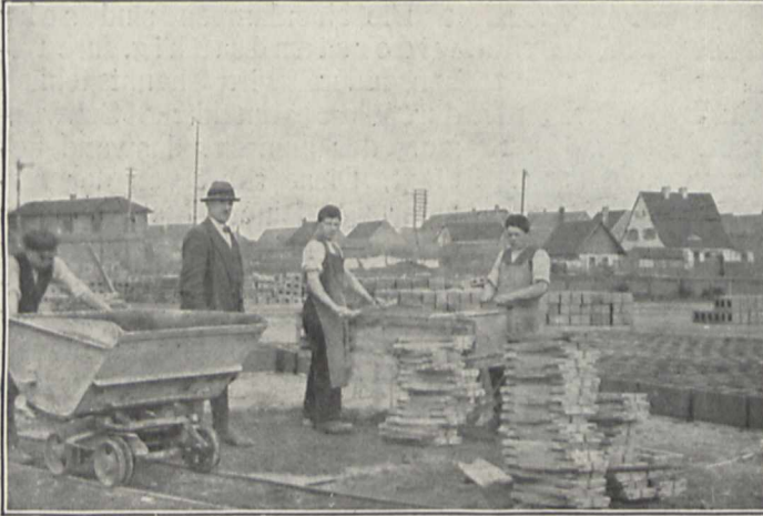
Fig. 3. Einstampfen der Steine.
