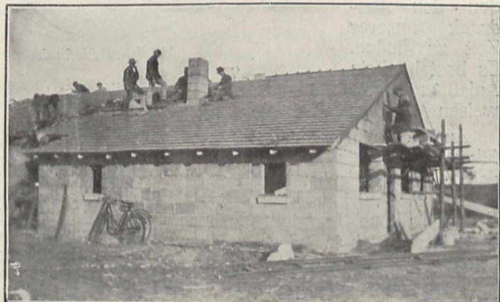
Fig. 8. Die nach 12 Tagen fertige Fabrikhalle von 36 m Länge und 11 m Tiefe.
