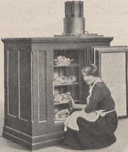
Fig. 3. Autofrigor in einen alten Schrank eingebaut.
