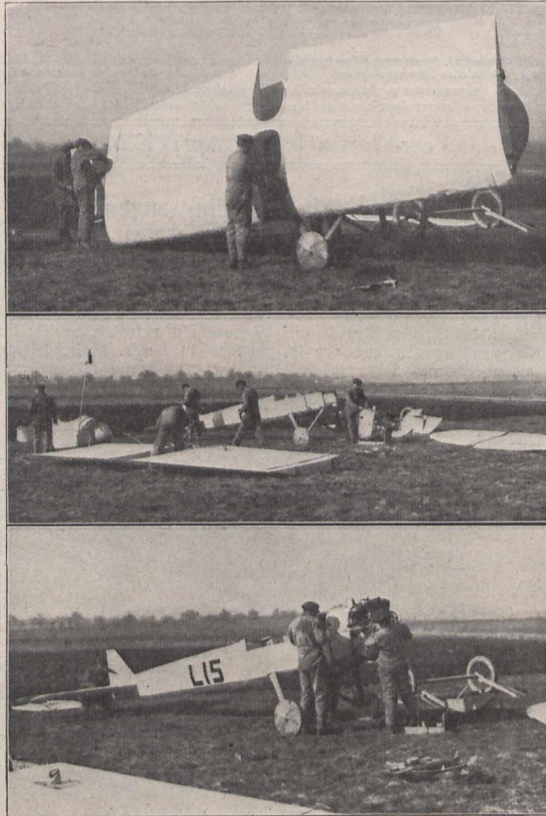
Fig. 2. Das Flugzeug beim Zusammenbau.
