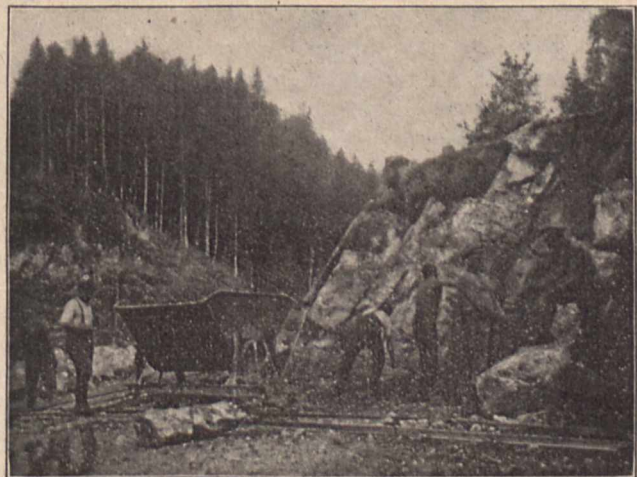
Fig. 4. Planierungsarbeiten am Stationsplatz.
