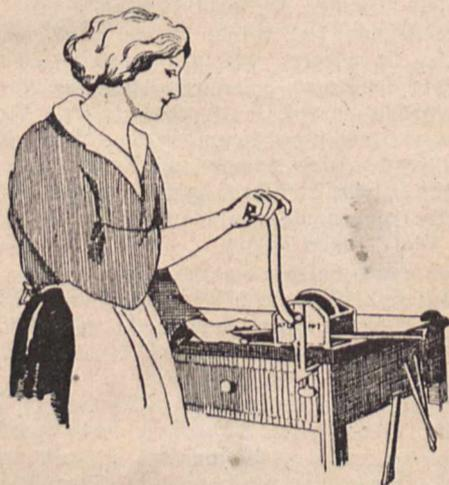
Linz a. D., Goethestraße 9, hat diesen Uebelständen dadurch abgeholfen, daß sie einen handlichen Apparat konstruiert und auf den Markt gebracht hat. Dieser Holzspreiber „Atlas“ hat folgende Vorteile: Eine Verletzung der Hand ist ausgeschlossen, es ist keinerlei Kraftaufwand notwendig, er arbeitet geräuschlos und ist unverwüsthlich.
