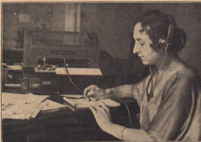
Fig. 4. Das Telegraphon der Berliner Telegraphon-A.-G., bei welchem die Sprechströme auf eine Wachswalze übertragen werden.
