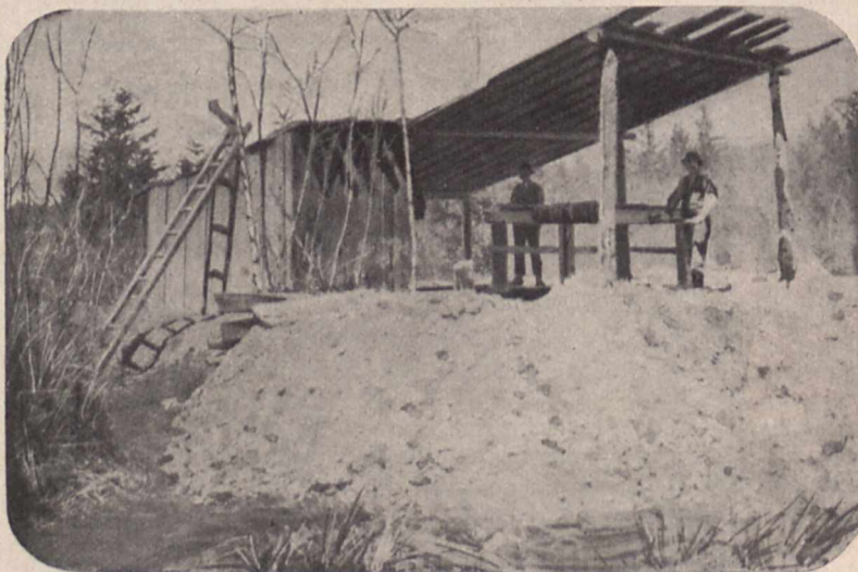
Fig. 4. Versuchsschacht mit Haspelförderung im Bayrischen Wald.
