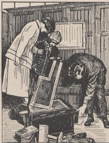
Der Röntgenapparat im Schuhladen. Anpassung eines Schuhs mit dem Röntgenapparat.
