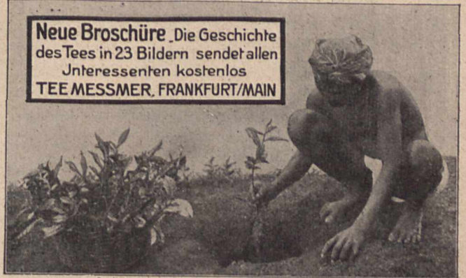
Anlage einer Teeplantage. Einpflanzen der Setzlinge.
