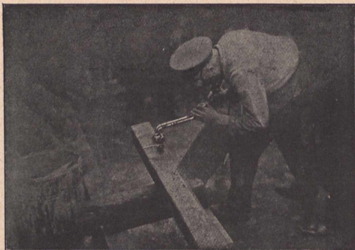
Fig. 2. Der Schneidebrenner (Sauerstoffgebläse) durchschneidet einen 12 cm Stahlblock in 1 Minute.
