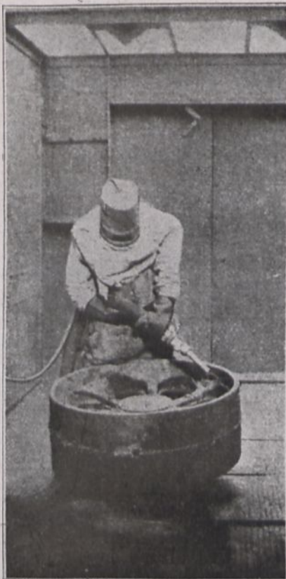
Bild 4. Reinigen mittels Sandstrahlgebläses.
