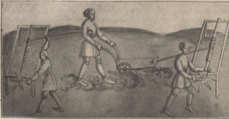
Seilpflügen. Nach einer Malerei des Weimarer Ingenieurbuches, 1430 bis 1520.
