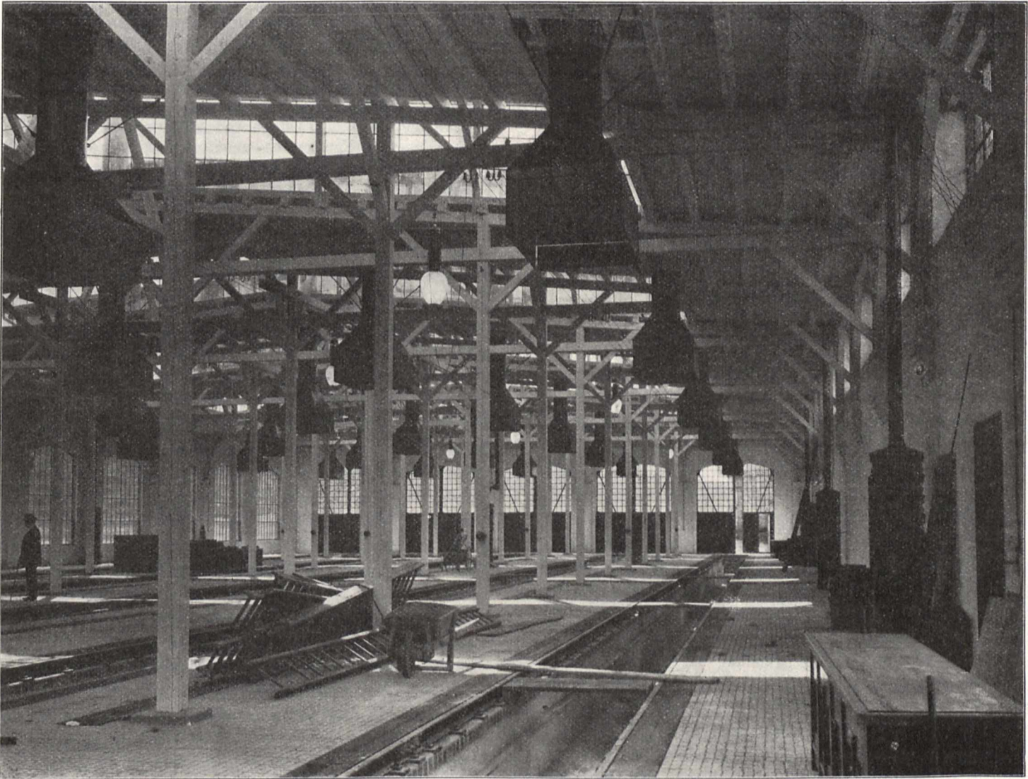
Abb. 23. Rechteckiger Lokomotivschuppen auf dem Bahnhof Grunewald.
