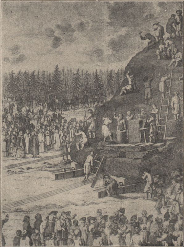
Transport des großen Sockels für das Denkmal Peters d. Gr. auf eisernen Kugeln, 1770.
