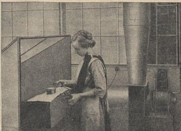
Verzinnen der Enden von Drahtlitzen durch Eintauchen in im elektrisch beheizten Schmelzkessel geschmolzenen Metall.
