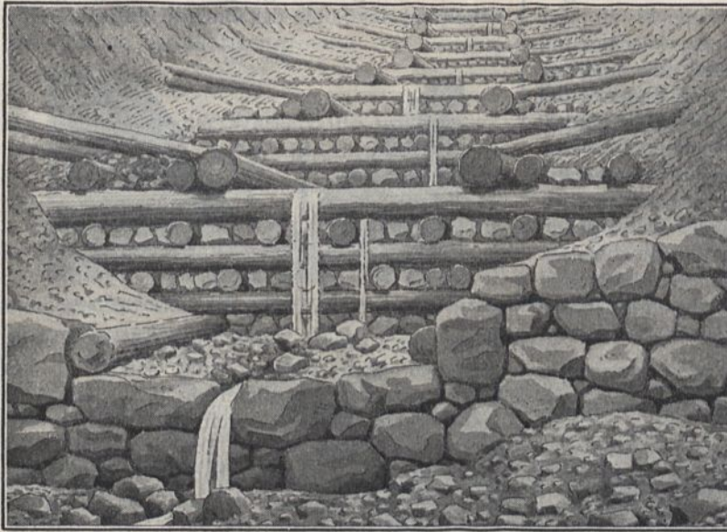
Sperrentreppe aus Holz und Stein.
