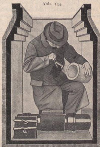
In die Kanalisierung eingebautes Zementprüfrohr zur Kontrolle der Abwässerwirkung.
