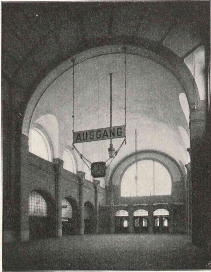
Abb. 10. Östliche Ausgangshalle des Querbahnsteigs.
