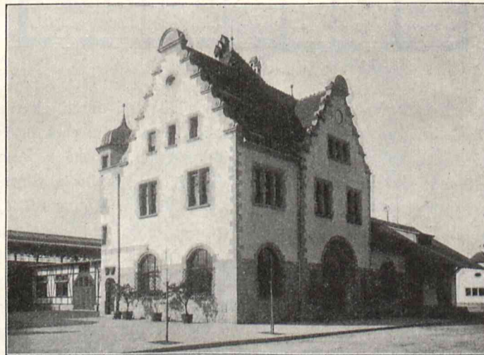
Abb. 8. Empfangsgebäude auf Bahnhof Straßburg-Neudorf.
