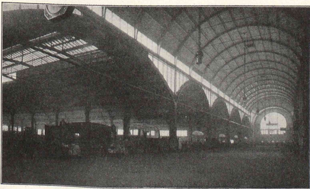
Abb. 15. Querbahnsteig und Bahnsteighallen.
