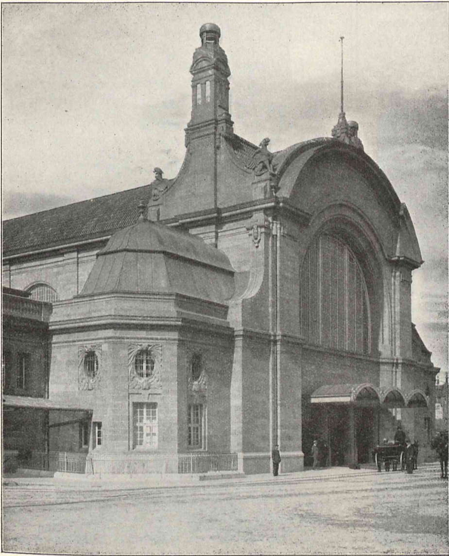
Abb. 8. Hauptaussgang auf der Ostseite.
