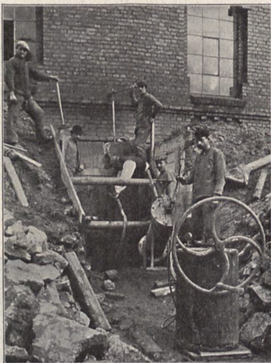
Dichtung eines geborstenen Gasometerbehälters auf den Städtischen Gaswerken zu Halle a. S. durch Einpressen neuen Mörtels mittels Handapparats in die Risse und Höhlungen des Mauerwerks.
