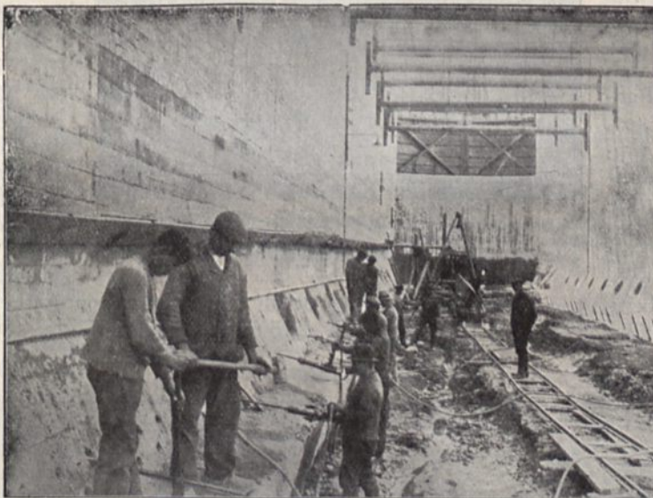
Abbohren der Fundamente an einer der vier Schleusen des Großschiffahrtsweges Berlin-Stettin bei Niederfinow.
