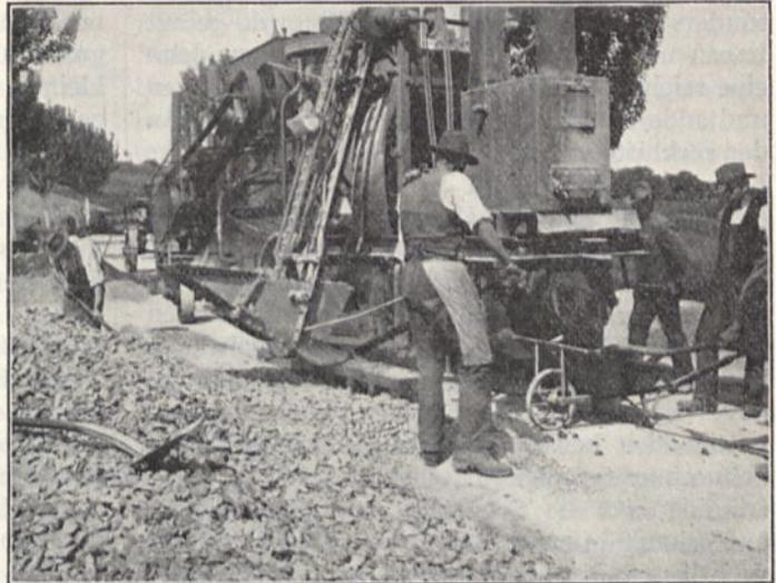
Staubfreie Automobilstraßen und ihre Entstehung: Ein anderes System zur Herstellung staubfreier Straßen, bei welchem die transportable Anlage auf einem großen Wagenrahmen aufgebaut ist und mit einem eingebauten Benzolmotor angetrieben und befördert wird.
