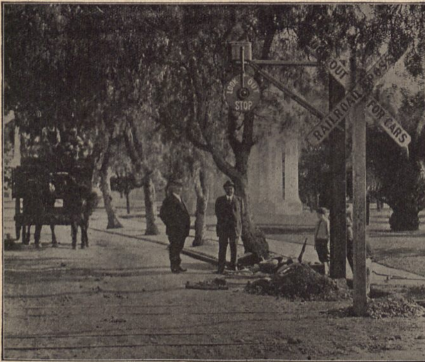
Selbsttätiges Warnungssignal (Läutewerk mit schwingender Scheibe) für unbewachte Eisenbahnübergänge. (Aus „Elektrotechnische Zeitschrift“ 1914, H. 32. Verlag Julius Springer, Berlin.)
