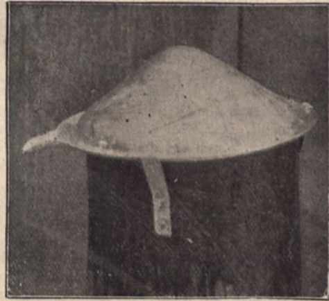
Ansicht der neuen Schutzkappe für das obere Ende von Holzmasten.
