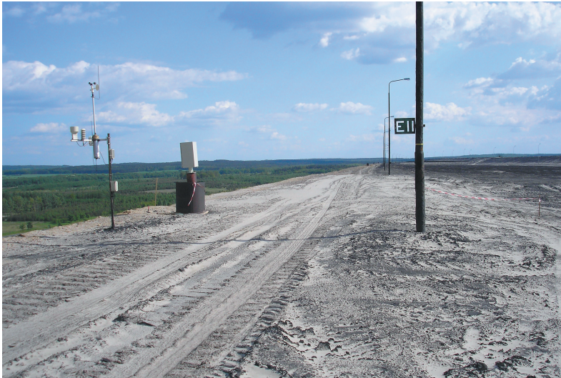
b) Measurement station "Zapora" Stacja pomiarowa "Zapora"
