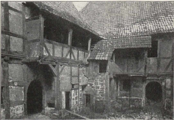
Abb. 4. Stalleingang mit Treppe und Galerie.
