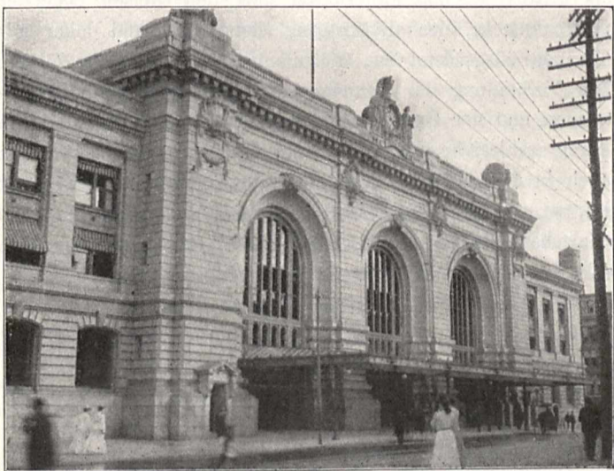
Abb. 8. Empfangsgebäude in Albany.
