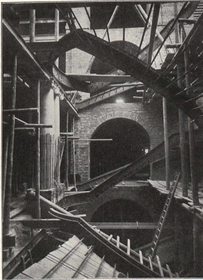
Abb. 9. Ausführung der elliptischen Haupttreppen.
