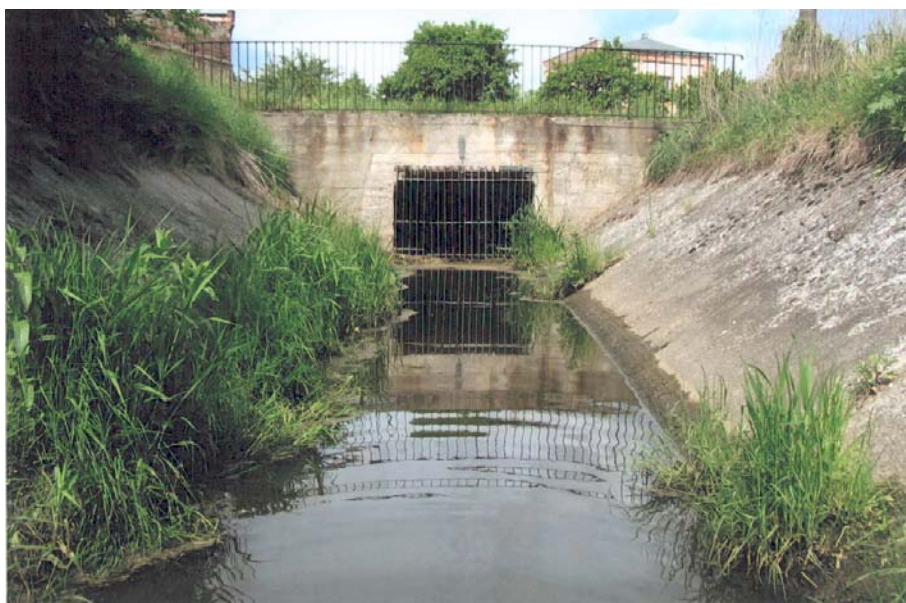
Fot. 4. Wlot kanału otwartego do kanału krytego pod Bielawicą Photo 4. Inflow of open channel into covered channel under Bielawica stream
