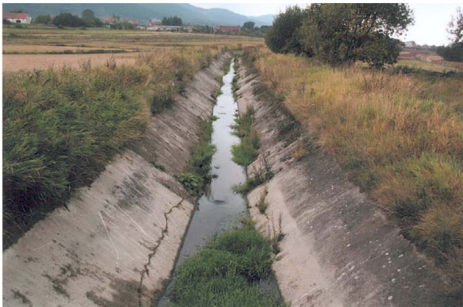
Fot. 3. Kanał otwarty Rdzawa – Bielawica Photo 3. Open channel Rdzawa – Bielawica
