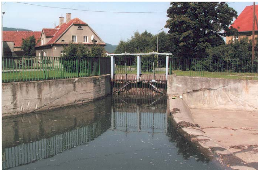
Fot. 5. Ujęcie na potoku Bielawica – wlot do kanału krytego Photo 5. Water intake on Bielawica stream – inflow into covered channel
