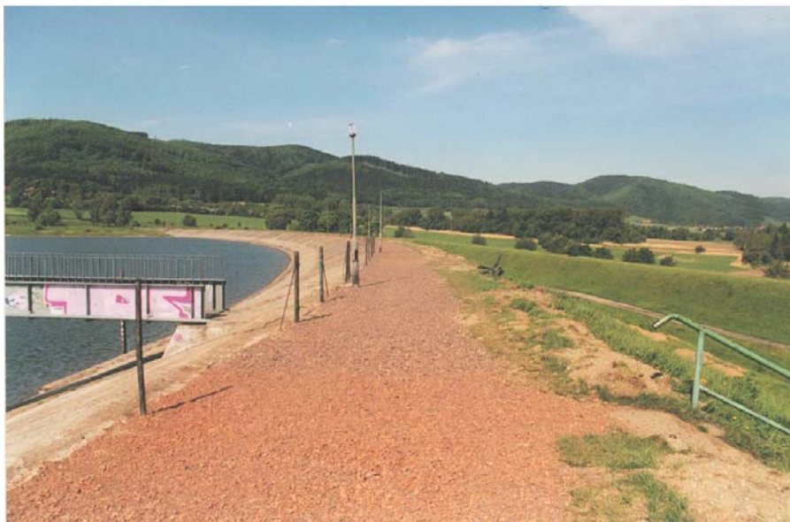
Fot. 20. Widok na koronę zapory po remoncie Photo 20. View on the dam crest after repair
