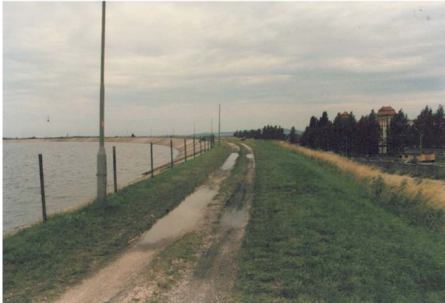
Fot. 19. Widok na koronę zapory w czasie powodzi Photo 19. View on the dam crest during the flood
