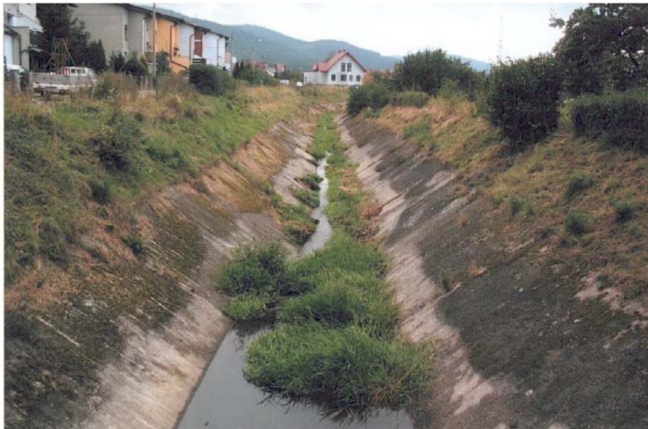
Fot. 7. Kanał otwarty Bielawica – zbiornik Photo 7. Open channel Bielawica stream – reservoir
