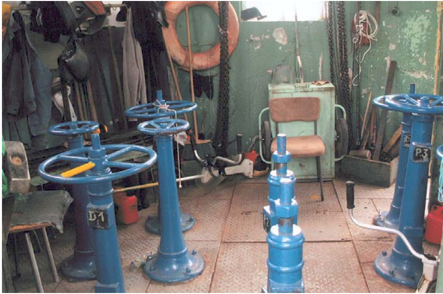
Fot. 13. Widok na wewnątrz wieży przelewowej Photo 13. View on the inside of overflow tower
