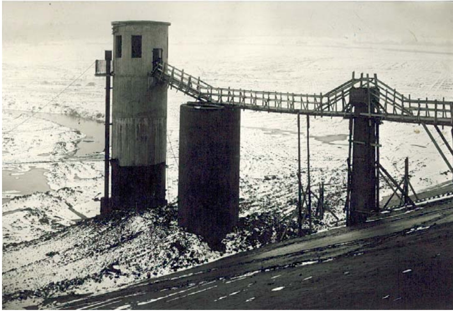
Fot. 11. Wieża ujęć i wieża przelewowa w trakcie budowy Photo 11. Intake tower and overflow tower in the time of construction
