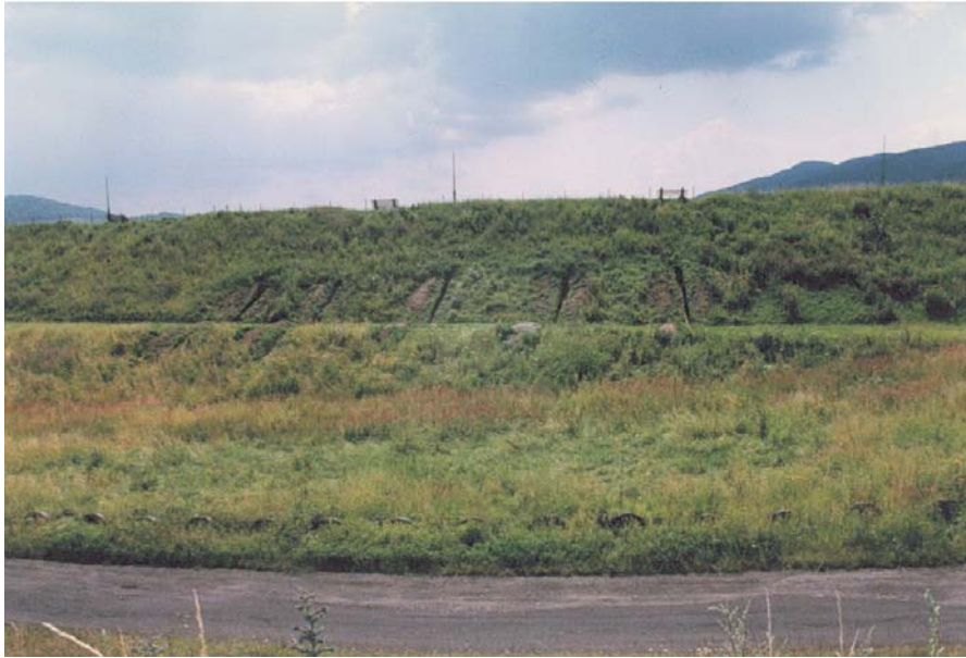
Fot. 21. System drenażowy w czasie odwodnienia skarpy odpowietrznej Photo 21. Drainage system during the draining of downstream embankment
