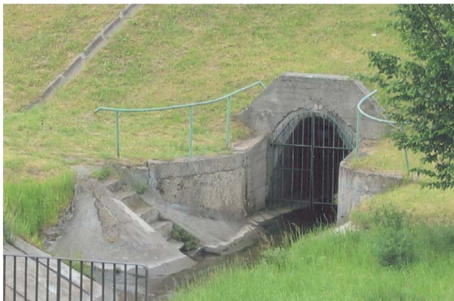
Fot. 16. Wylot z przepustu pod zaporą Photo 16. Outlet from culvert under dam
