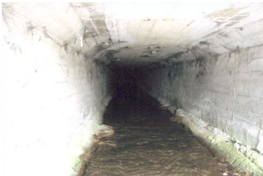
Fot. 6. Kanał kryty pod Bielawicą Photo 6. Covered channel under Bielawica stream
