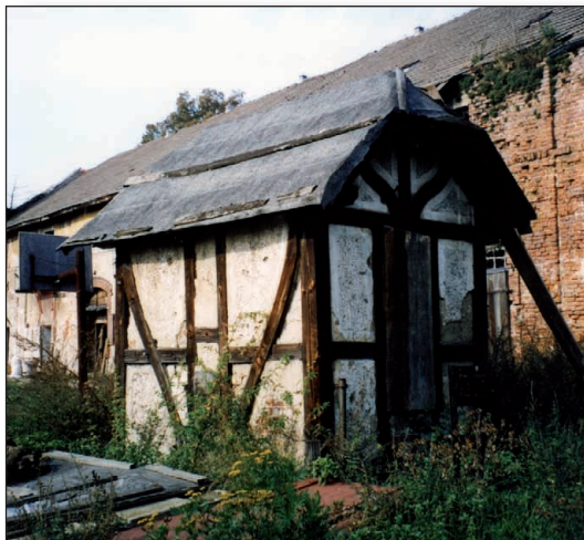
Fot. 21. Boreczek, studnia (fot. autorka) Phot. 21. Boreczek, the well
