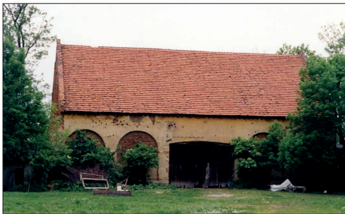
Fot. 40. Krajno, stodoła (fot. autorka) Phot. 40. Krajno, the barn
