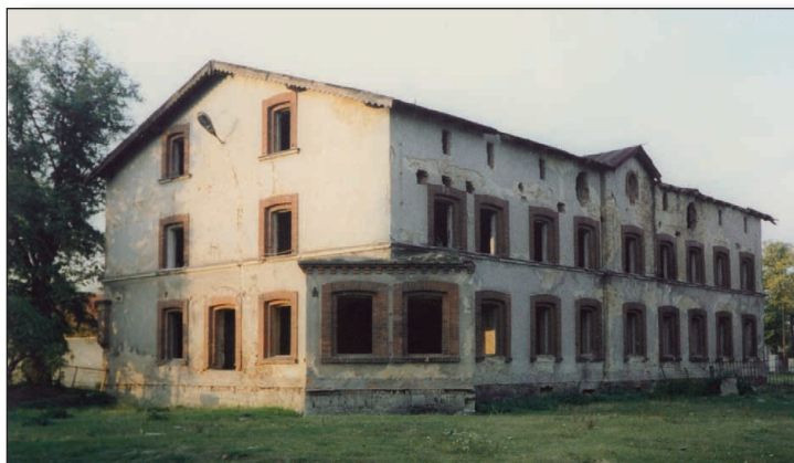
Fot. 6. Komorowice, oficyna dworska (fot. autorka) Phot. 6. Komorowice, the outhouse
