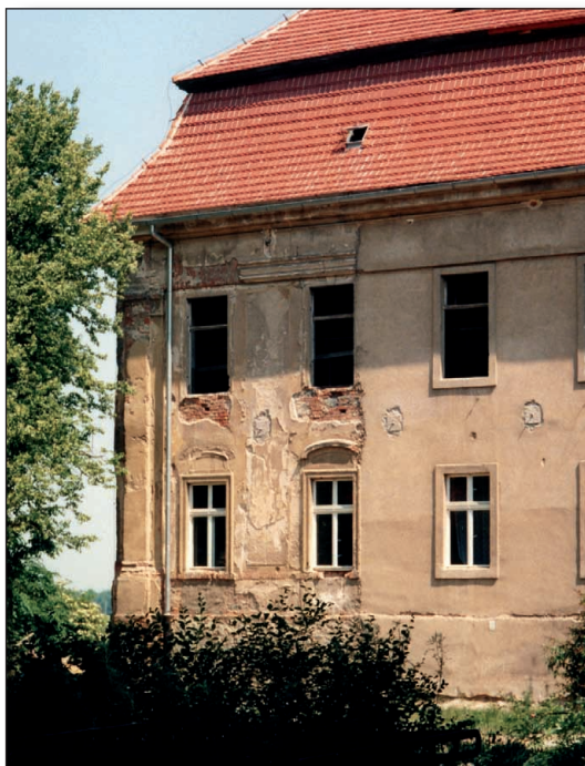
Fot. 71. Świątniki, fragment elewacji pałacowej w trakcie prac remontowych (fot. autorka) Phot. 71. Świątniki, the fragment of the palace's elevation during renovation works
