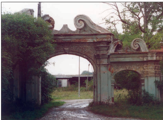
Fot. 59. Galowice, renesansowa brama wjazdowa (fot. autorka) Phot. 59. Galowice, the Renaissance gateway
