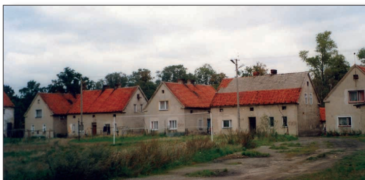
Fot. 13. Żerniki Wielkie, budynki mieszkalne pracowników folwarcznych (fot. autorka) Phot. 13. Żerniki Wielkie, the line of old farm's houses
