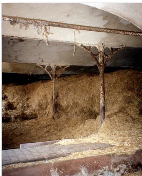
Fot. 26. Jezierzycze Małe, wnętrze obory poprzecznej (fot. autorka) Phot. 26. Jezierzycze Małe, the crosses cowshed's interior
