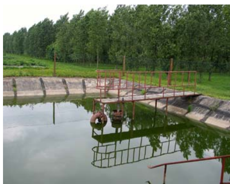
Fot. 2. Zbiornik akumulacyjny – Brzeźno Phot. 2. The accumulated tank – Brzeźno
