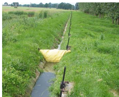
Fot. 3. Zastawka kierująca na rowie doprowadzającym – Brzeźno Phot. 3. The water gate on supply ditch – Brzeźno
