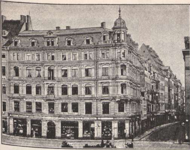
Kaffee National. Markt 16. Besitzer: M. Weber u. Genossen. Architekt: Bruno Grimm. Erbaut 1877.
