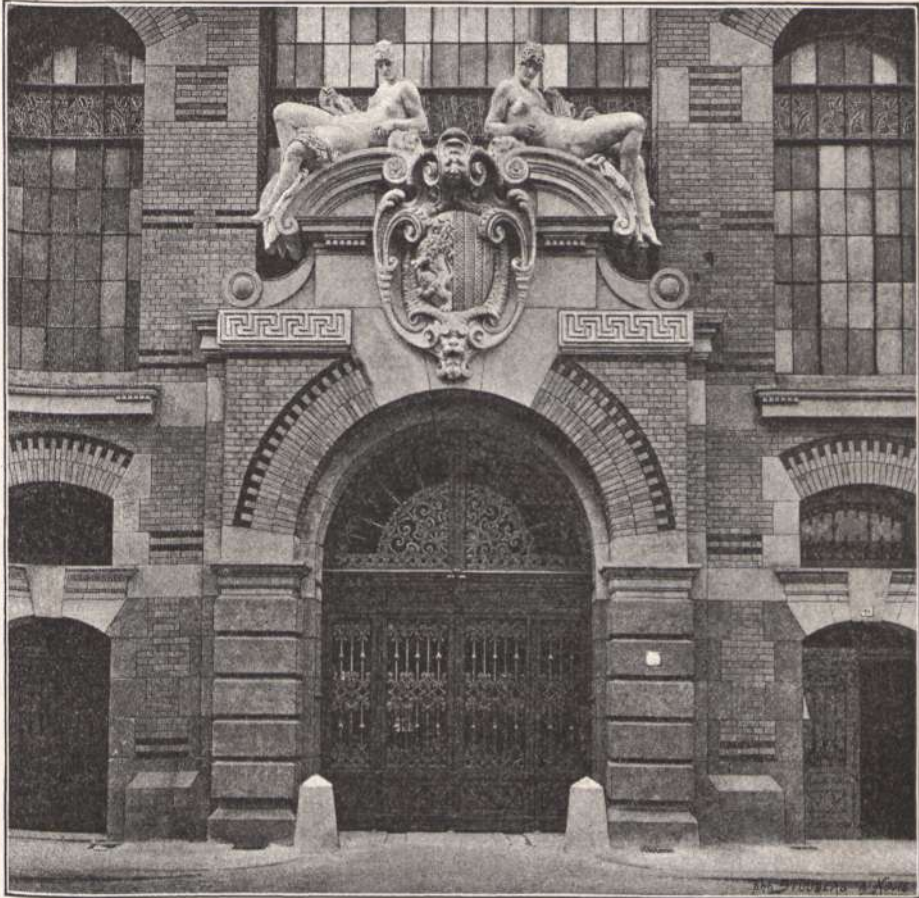
Die Markthalle. (Portal am Roßplatz.)
