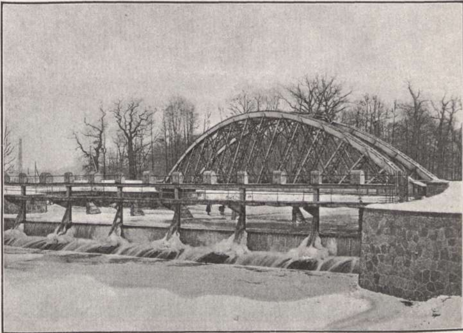
Gitterbrücke über die Pleiße und Wehranlage nach dem Flutkanal.
