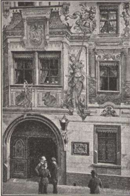
Der Thüringer Hof. (Detailansicht.)
