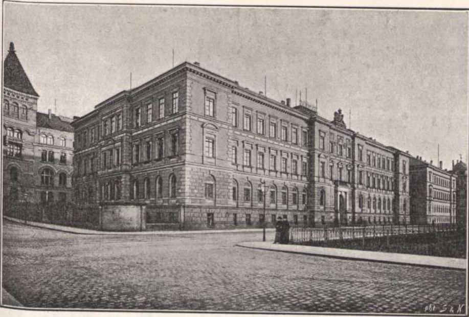
Ansicht an der Harfortstraße.
