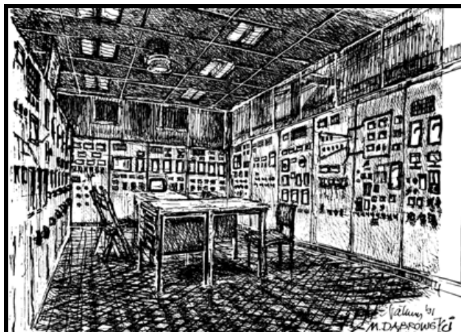
Ryc. 13. Wnętrze nastawni turbozespołów nr 1 i 2 Pic. 13. The Nos 1 and 2 turbine sets control room inside (Wydawnictwo URBANISTYKA 1992, Wrocław)
