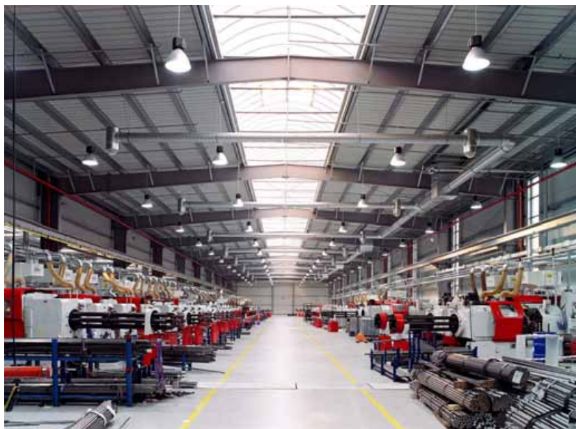
Fot. 195. Parker Hannifin – hala produkcyjna (fot. Maćków Pracownia Projektowa) Photo 195. Parker Hannifin – production hall (photo Maćków Design Bureau)
