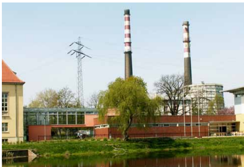
Fot. 121. Łącznik pomiędzy gimnazjum gminnym a halą sportową (fot. autorki) Photo 121. Connection between Gimnazjum Gminne (junior secondary school) and the gym (photo author)
