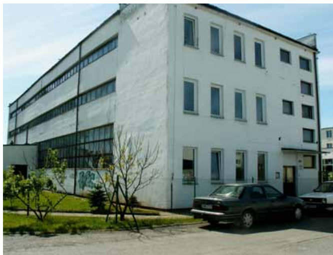
Fot. 101. Budynek Stacji Uzdatniania Wody (fot. autorki) Photo 101. Water Treatment Station building (photo author)
