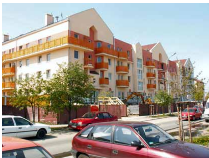
Fot. 66. Zabudowa wielorodzinna, czterokondygnacyjna, w trakcie prac wykończeniowych, 2006 r. (fot. autorki)
