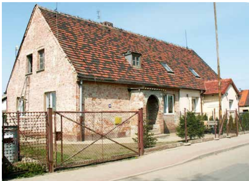
Fot. 44. Stary budynek jednokondygnacyjny, typu bliźniaczego w trakcie odrestaurowywania (fot. autorki)
