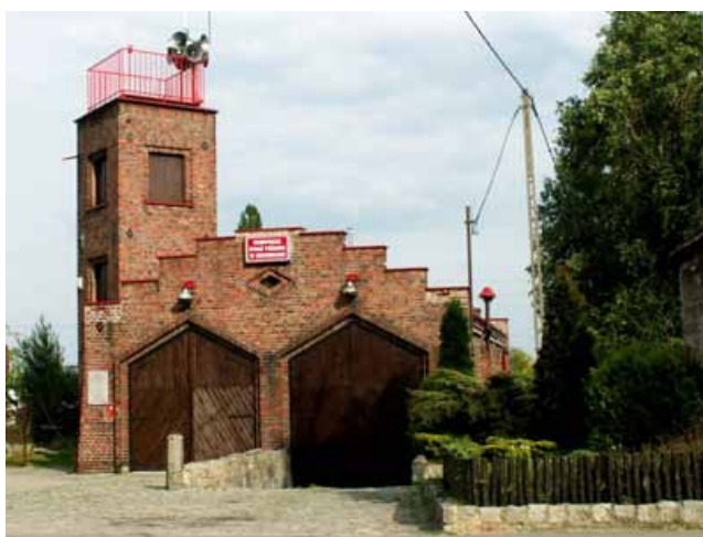
Fot. 143. Budynek Ochotniczej Straży Pożarnej w Siechnicach (fot. autorki) Photo 143. Voluntary Fire Brigade building at Siechnice (photo author)
