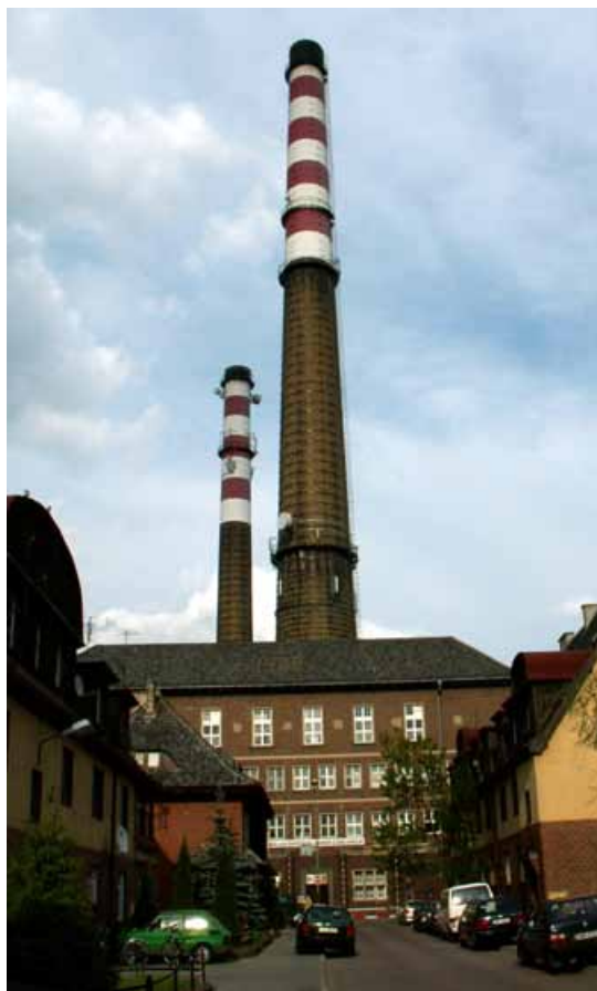
Fot. 109. Budynek administracyjny główny Elektrociepłowni „Czechnica” (fot. autorki) Photo 109. Main administration building of the Thermal-Electric Power Station „Czechnica” (photo author)
