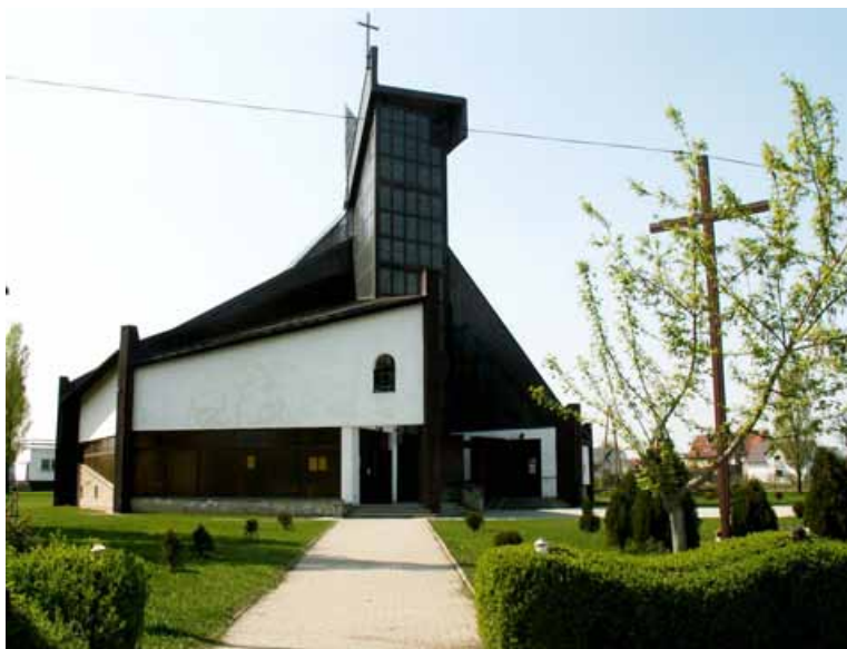
Fot. 150. Kościół pw. Niepokalanego Serca Najświętszej Marii Panny w Siechnicach – elewacja od strony północno-wschodniej (fot. autorki)
