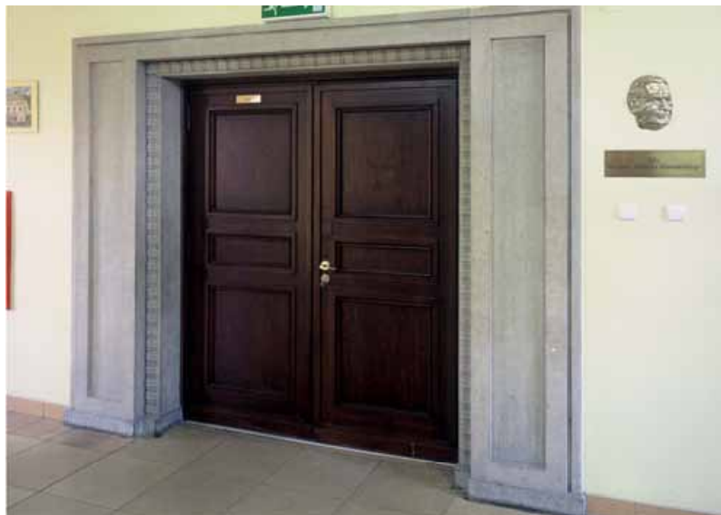
Fot. 117. Wejście do Auli im. Prof. T. Konopińskiego w gimnazjum gminnym (fot. Maćków Pracownia Projektowa)
