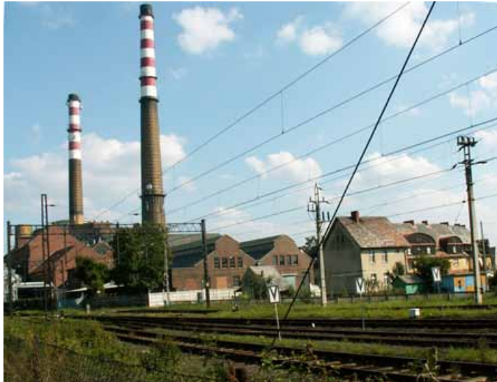
Fot. 97. Zabudowa przemysłowa – Elektrociepłownia „Czechnica” (fot. autorki) Photo 97. Industrial buildings – thermal-electric power station „Czechnica” (photo author)
