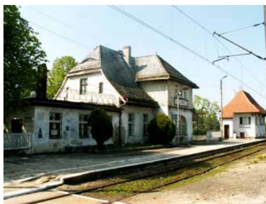
Fot. 146. Budynek stacji kolejowej (fot. autorki) Photo 146. Railway Station building (photo author)
