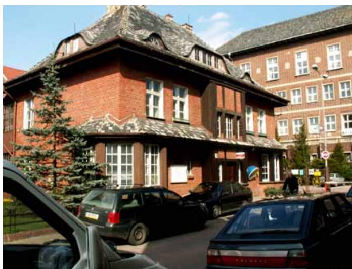
Fot. 108. Budynek wartowni z ok. 1920 roku (fot. autorki) Photo 108. Guardhouse, ca 1920 (photo author)
