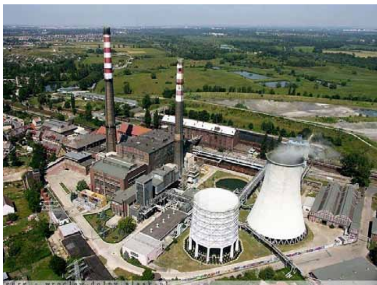
Fot. 206. Elektrociepłownia „Czechnica” z lotu ptaka (źródło: www.siechnice.com.pl )
