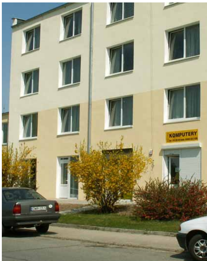
Fot. 80. Usługi komputerowe w budynku hotelu „Azalia” (fot. autorki) Photo 80. IT service in the hotel building „Azalia” (photo author)
