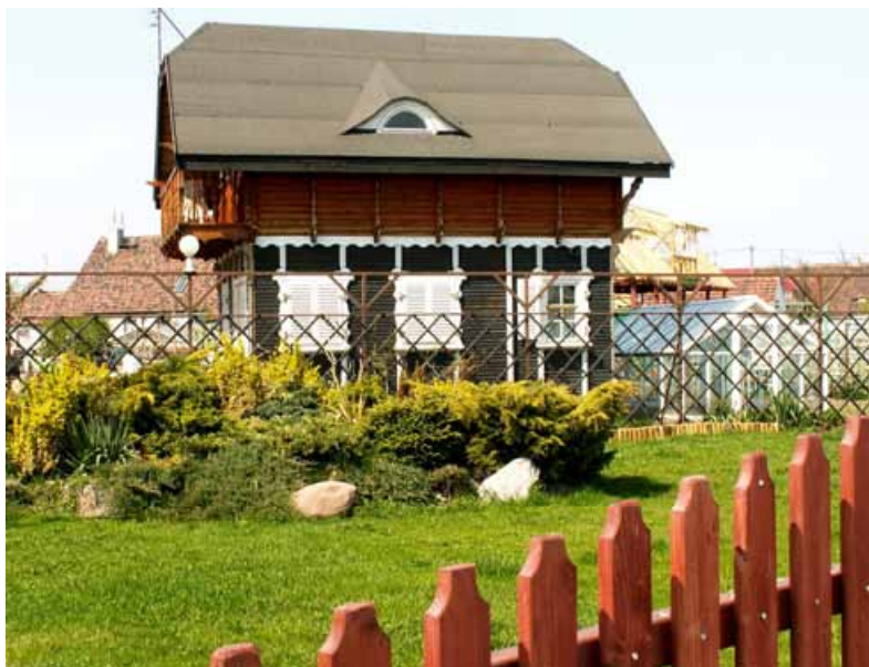
Fot. 52. Nietypowy, drewniany obiekt rekreacyjny, wolno stojący producenta stolarki budowlanej (fot. autorki)
