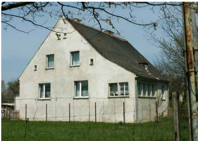
Fot. 46. Najstarsza zabudowa jednorodzinna przy ul. Polnej po rewitalizacji (fot. autorki) Photo 46. The oldest single-family housing in Polna Street. After restoration (photo author)
