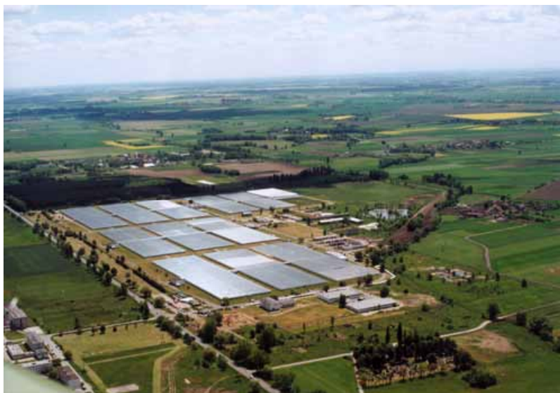
Fot. 189. PPO „Siechnice” – widok z lotu ptaka (fot. własnością przedsiębiorstwa)
