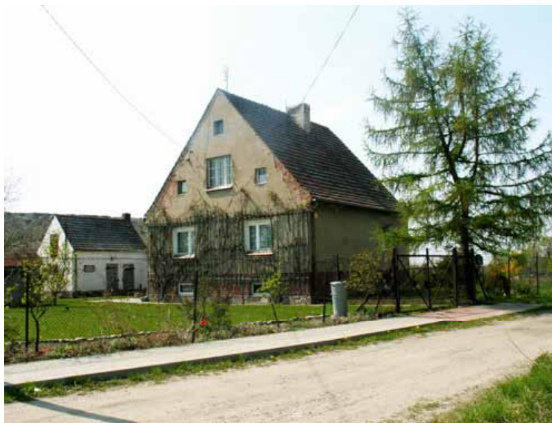
Fot. 42. Stara parterowa zabudowa zagrodowa przy ul. T. Kościuszki (fot. autorki) Photo 42. Old two-floor homestead in Kościuszko Street (photo author)
