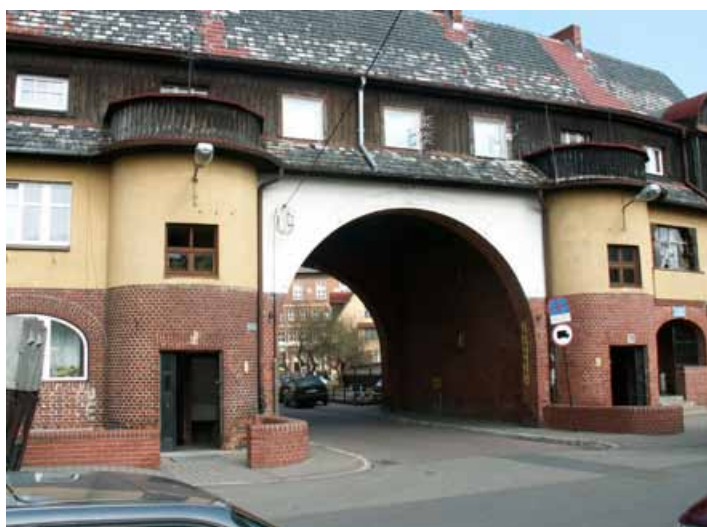
Fot. 106. Brama wjazdowa na teren Elektrociepłowni „Czechnica” – widok od strony ulicy (fot. autorki) Photo 106. Gate to the Thermal-Electric Power Station „Czechnica” – view from the street (photo author)
