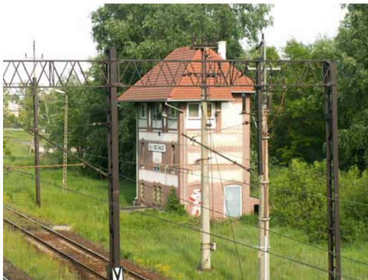
Fot. 147. Infrastruktura kolejowa – stacja rozrządowa (fot. autorki) Photo 147. Railway infrastructure – marshalling station (photo author)
