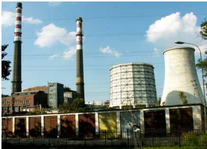
Fot. 105. Widok na Elektrociepłownię „Czechnica” (fot. autorki) Photo 105. View of the Thermal-Electric Power Station „Czechnica” (photo author)
