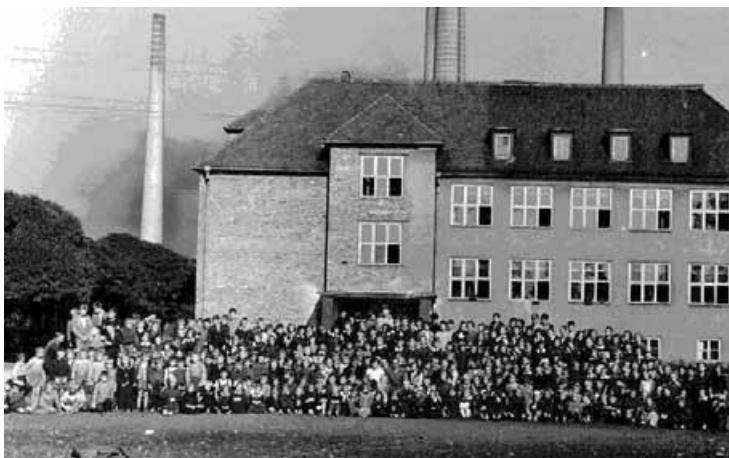
Fot. 9. Budynek szkoły podstawowej starej (źródło: www.siechnice.com.pl ) Photo 9. Old primary school (source: www.siechnice.com.pl )
