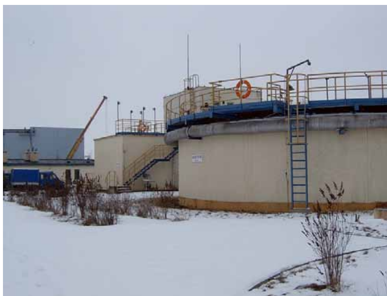
Fot. 103. Oczyszczalnia ścieków (źródło: www.zgksiechnice.pl ) Photo 103. Sewage Treatment Plant (source: www.zgksiechnice.pl )
