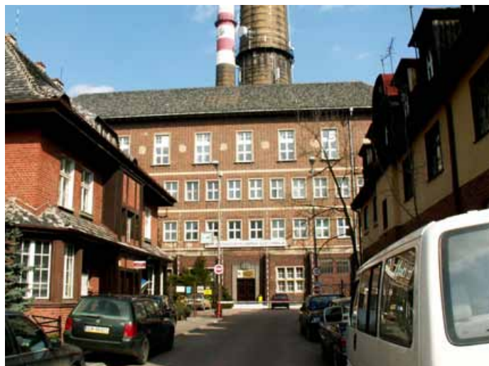
Fot. 107. Budynek administracyjny z 1925 roku (fot. autorki) Photo 107. Administration building, 1925 (photo author)
