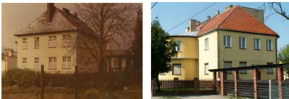
Fot. 161. Żłobek Huty „Siechnice” przy ul. Kolejowej 15 w 1985 r. (fot. z lewej – własnością Miejskiej Biblioteki Publicznej w Siechnicach), aktualnie Ośrodek Zdrowia (zdjęcie z prawej fot. autorki)
