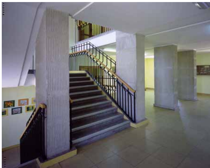
Fot. 118. Klatka schodowa gimnazjum gminnego – zachowane stare balustrady (fot. Maćków Pracownia Projektowa)
