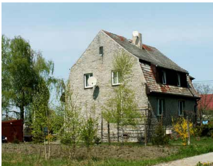
Fot. 39. Nieotynkowany budynek z kamienia (brak metryczki historycznej), ul. T. Kościuszki (fot. autorki) Photo 39. Unplastered stone building (documents missing) in Kościuszko Street (photo author)
