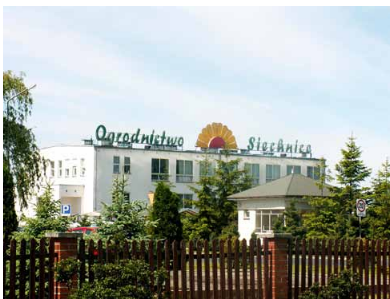
Fot. 188. PPO „Siechnice”, budynek administracji (fot. autorki)
