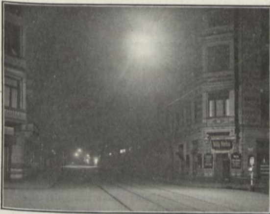
Grunaerstraße in Dresden: Frühere Beleuchtung mit Effektbogenlampen, nach Mitternacht.
