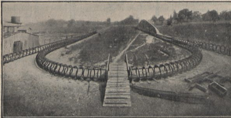
Versuchsanlage der elektrischen Rohrpost. Nach „Scientific American“.
