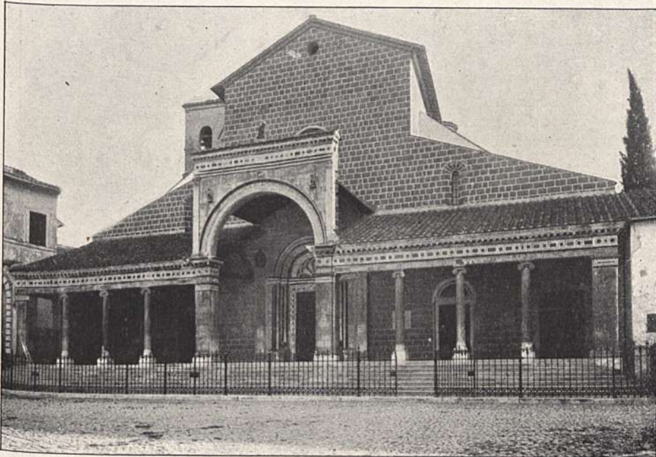
Abb. 2. Fassade des Domes zu Civitè Castellana.
