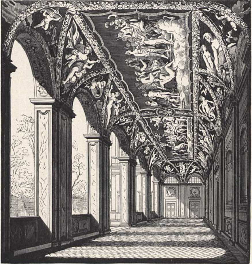
Abb. 326. Halle in der Farnesina zu Rom.
