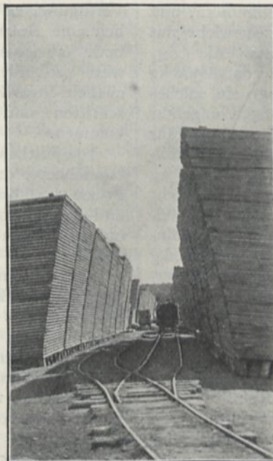
Zur Verladung fertige Bretter.
