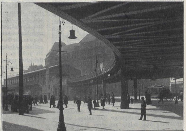
Viadukt und Haltestelle am Rödingsmarkt.
