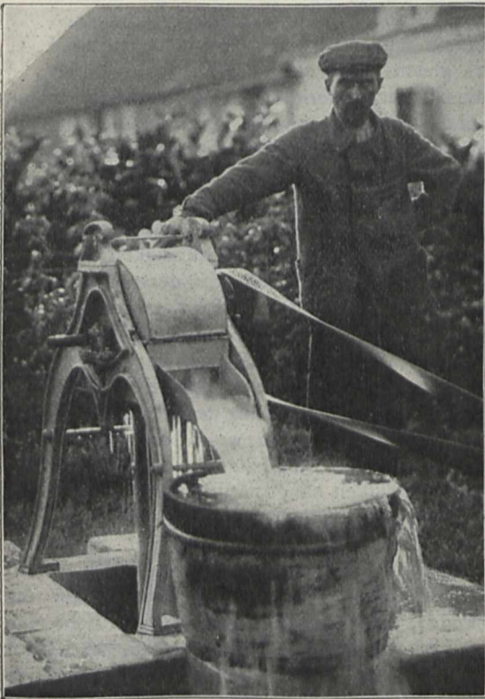
Kettenpumpe mit Motorantrieb.
