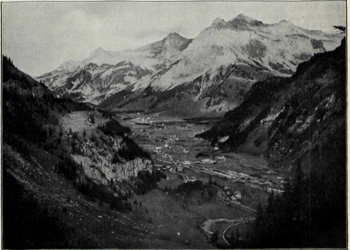
Kandersteg, Nordseite des Lötschbergtunnels.
