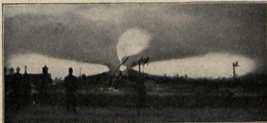
durch mit 8 Atmosphären Druck gegebene Wassermengen zu löschen. Die Flammen wurden dann wieder entzündet, da sie bis zu der beabsichtigten Fassung der Erdgasquelle brennend bleiben sollen. Das Erdgas besteht aus Kohlenwasserstoffgasen von hoher Heizkraft, aber relativ geringem Leuchtvermögen. Über die Dauer der Ergiebigkeit der Quelle lässt sich zurzeit nichts aussagen, zumal man noch keine einwandfreien Anhaltspunkte dafür hat, ob sich das Gas über Erdöl- oder Salzlagern bildete.
