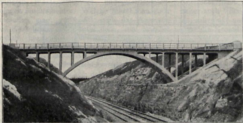
Wegüberführung bei Otting in Bayern; Spannweite 24 m. Ausgeführt von Gebr. Rank in München. (Nach Deutsche Bauzeitung.)
