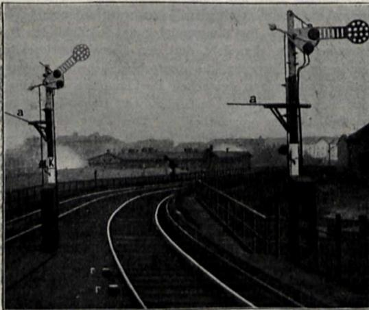
welchen Gründen ein Haltsignal überfahren wurde. An jedem Mast der Ausfahrtsignale ist ein dem Gleis zugewendeter Arm *a* (Abb. 250) angebracht, der gleichzeitig mit der Zugvorrichtung des Signallügels bedient
