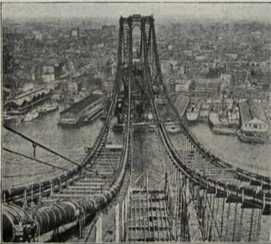
Die Manhattan-Brücke von Brooklyn aus gesehen (links sind an den Tragscilen die Stahlgussäittel für die Hängeseile und die Montagebrücke erkennbar).
