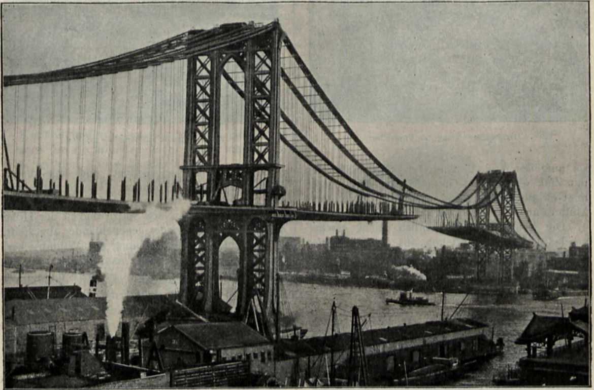
Montage der Brückenbahn der Manhattan-Brücke.
