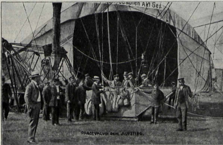
Gondel des Parseval 3 vor dem Aufstieg. Im Hintergrunde die Ballonhallen.
