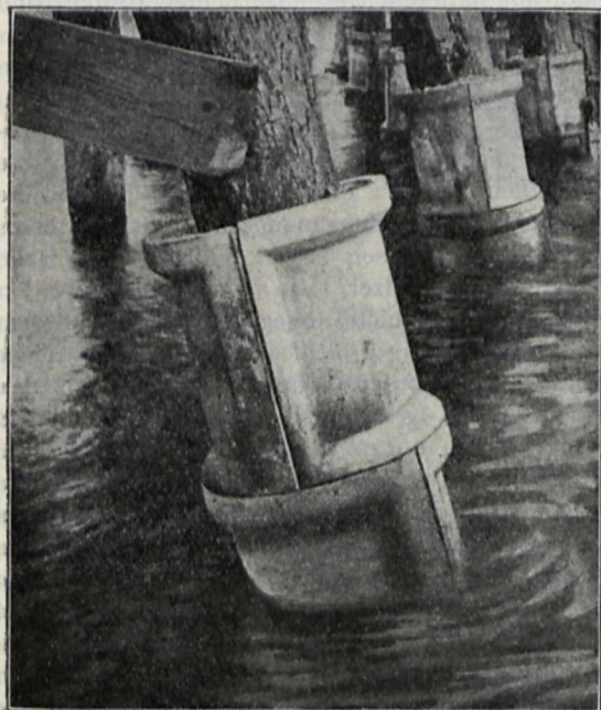
Betonröhren als Schutz gegen Bohrwürmer.
