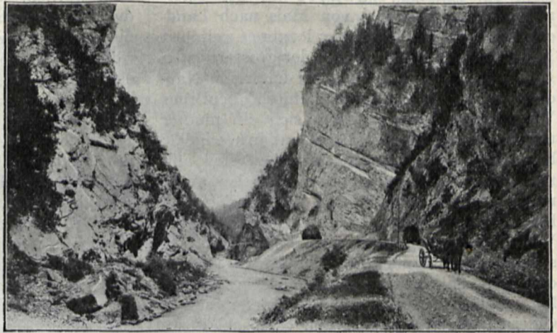
Davoser Landwasserstrasse. Ausgang der Zügen.
