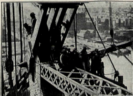
Eintreiben eines Gelenkbolzens von 350 mm Durchmesser und 1,5 m Länge.
