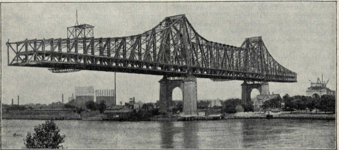
Die in Montage begriffene neue Strassenbrücke über den East River in New York.
