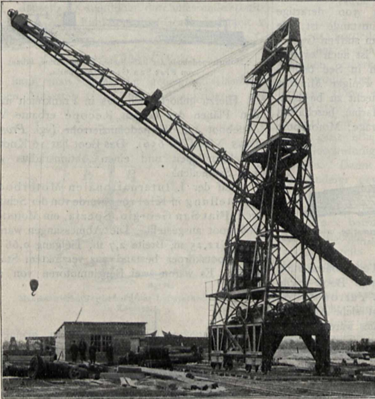
Turm-Verladekran in Arbeitsstellung.
