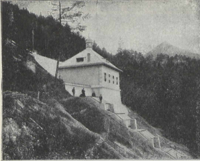
Wasserschloss mit Leerlauf.
