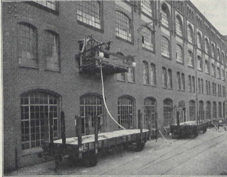
Verladung des Kabels direkt aus dem Kabelwerk auf Eisenbahnwaggons.
