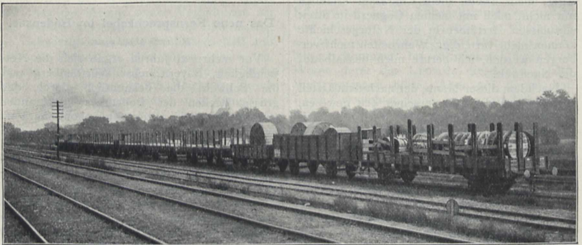
Der Eisenbahnzug mit dem Bodenseekabel.
