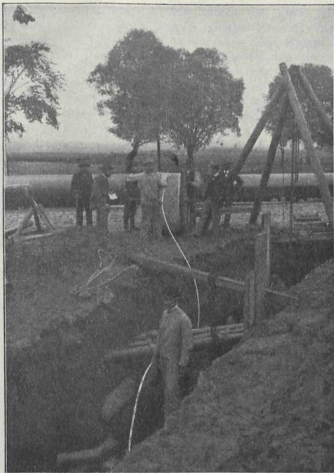
Abrollen des Kabels von der Kabeltrommel zum Verlegen.
