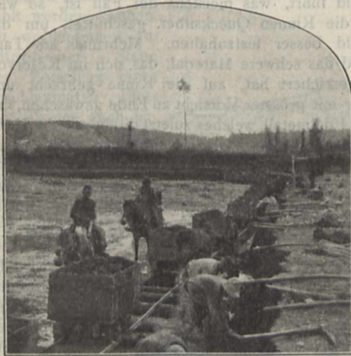
Aufdeckungsarbeiten (Graben von Sand in Wagonets).
