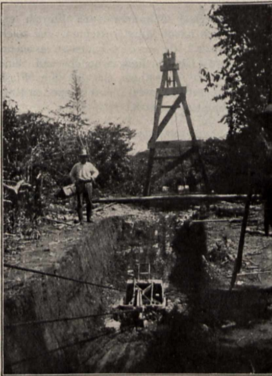
Amerikanischer Kabelbagger, von Ingenieur Vogt im Chocó (Columbien) aufgestellt. Kabelschaufel während der Füllung.
