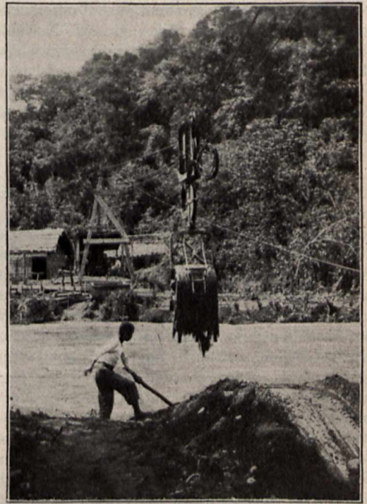
Amerikanischer Kabelbagger, von Ingenieur Vogt im Chocó (Columbien) aufgestellt. Kabelschaufel während der Füllung.
